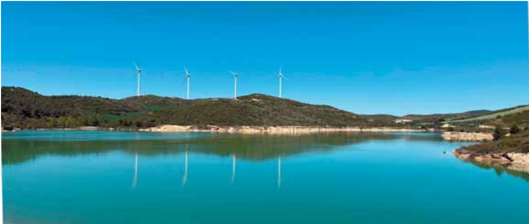
Imagen de la balsa de Artajona del Canal de Navarra, punto final de la primera fase del Canal de Navarra.
